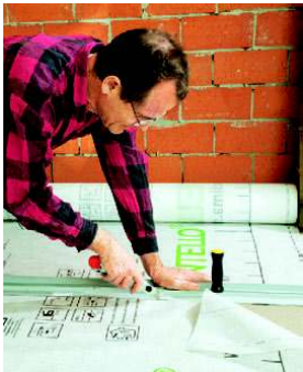
Tvaika membrānas: Uzdrūkatas paliginlijas un šabloni būtiski atvieglo materiāla precīzu piegriešanu.
