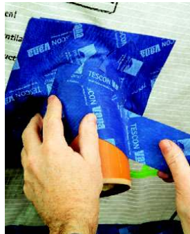
Limlente: Ar elastīgu limlentes sloksni arī tādu problemātisku vietu kā caurules izvadu iespējams labi noblīvēt.
