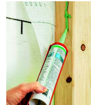
Līmes masa: Pieslēgumiem pie balkņiem vai sānu sienām piemērota līme no kārtīdžiem.
